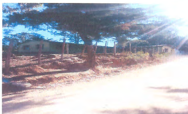
Foto 2: Mejoramiento de cerco perimetral
