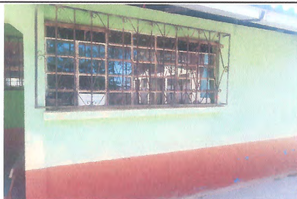
Foto 3: Mejoramiento de pintura exterior
