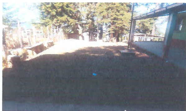
Foto 1: Mejoramiento de losa de patio
